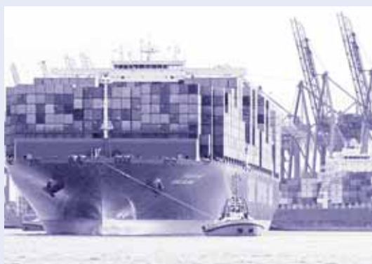
Hafen Hamburg Containerterminal.
